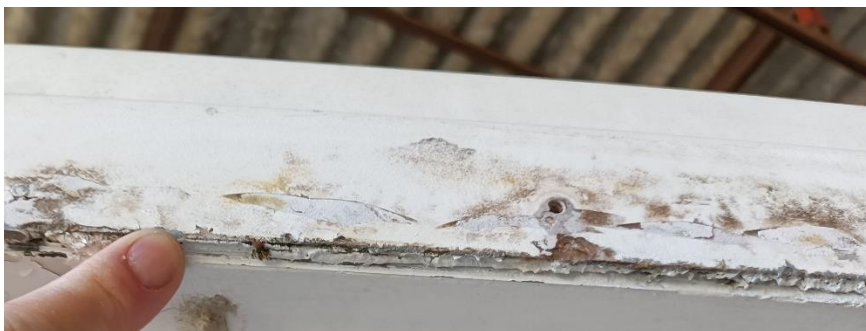
Figura 12: giunzione scafo coperta con crepe e distacchi.
