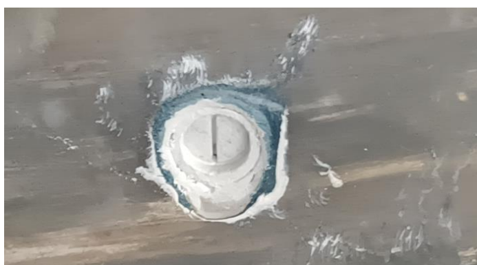
Figura 6: le teste delle nuove viti prima della stuccatura.
