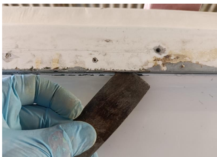
Figura 13: canale fra scafo e coperta per il sigillante.
