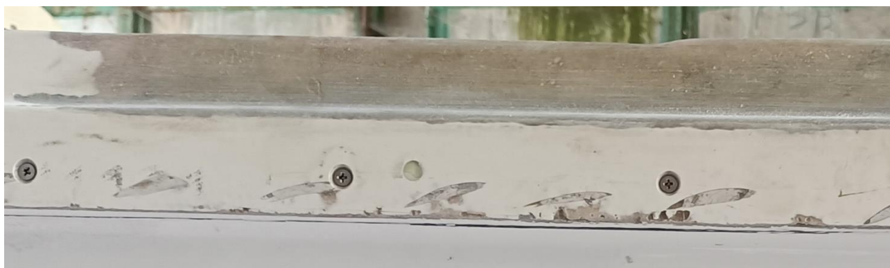
Figura 14: viti di collegamento scafo-coperta e falchetta riparata.
