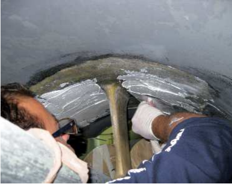
Il tunnel viene stuccato
