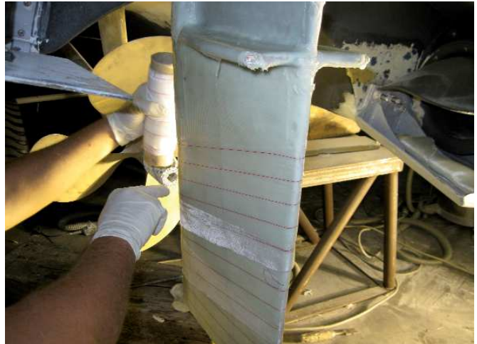
Si posiziona il PeelPly sopra il tessuto biafficato
